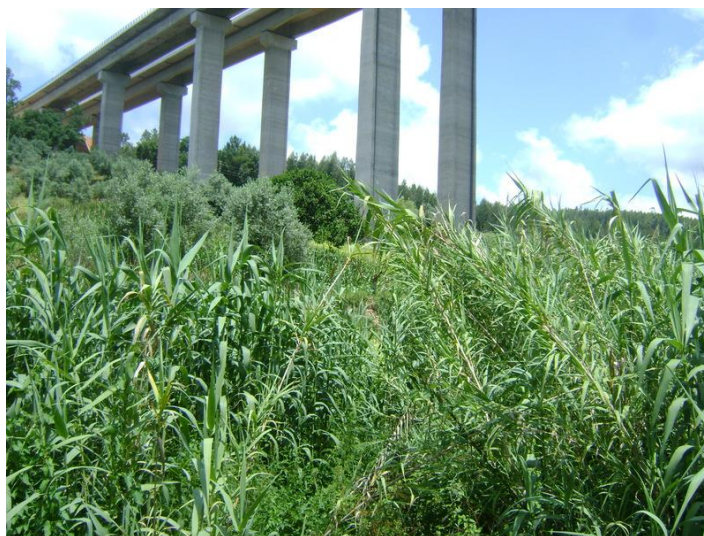
Figura 1 – Ponto de recolha de águas superficiais – Ribeira do Vale do Inferno – Montante
