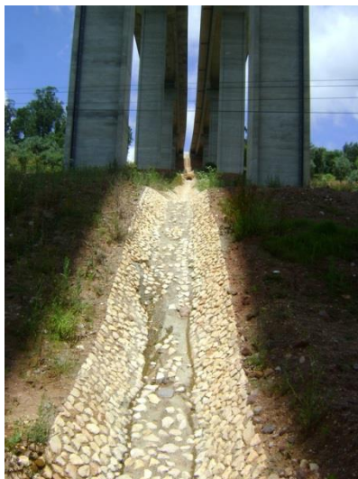
Figura 9 – Ponto de descarga das águas de escorrência da via localizado ao km 0+150
