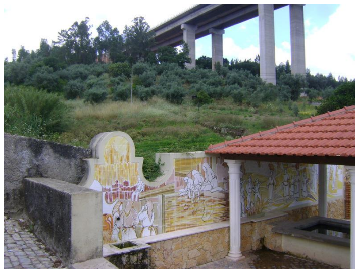
Figura 10 – Ponto de recolha de águas subterrâneas P1, ao Km 0+150.
