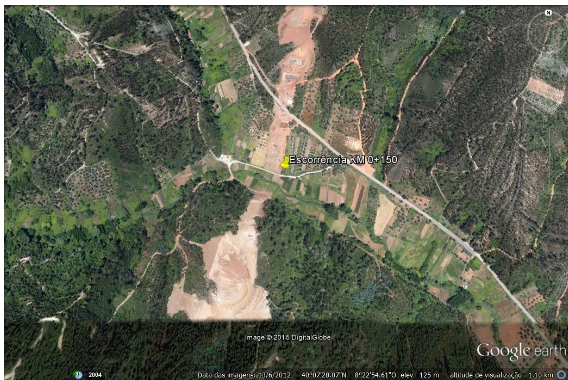
Figura AI.5 – Ponto de recolha das águas de escorrência, cerca do km 0+150.
